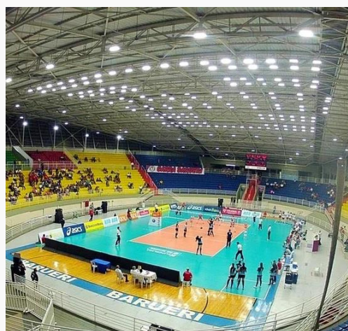
ILUMINAÇÃO LED EM ARENA
